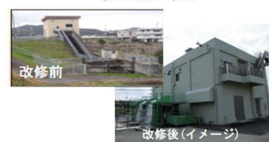
排水機の改修
